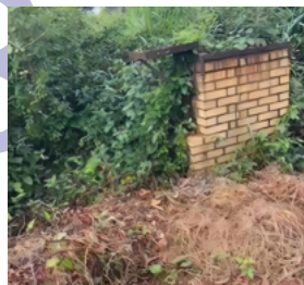
Précédant incinérateur remplacé après son arrêt de fonctionnalité
