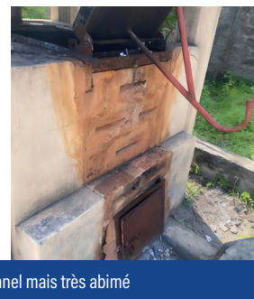
Incinérateur non utilisé à cause de son état de défectuosité
